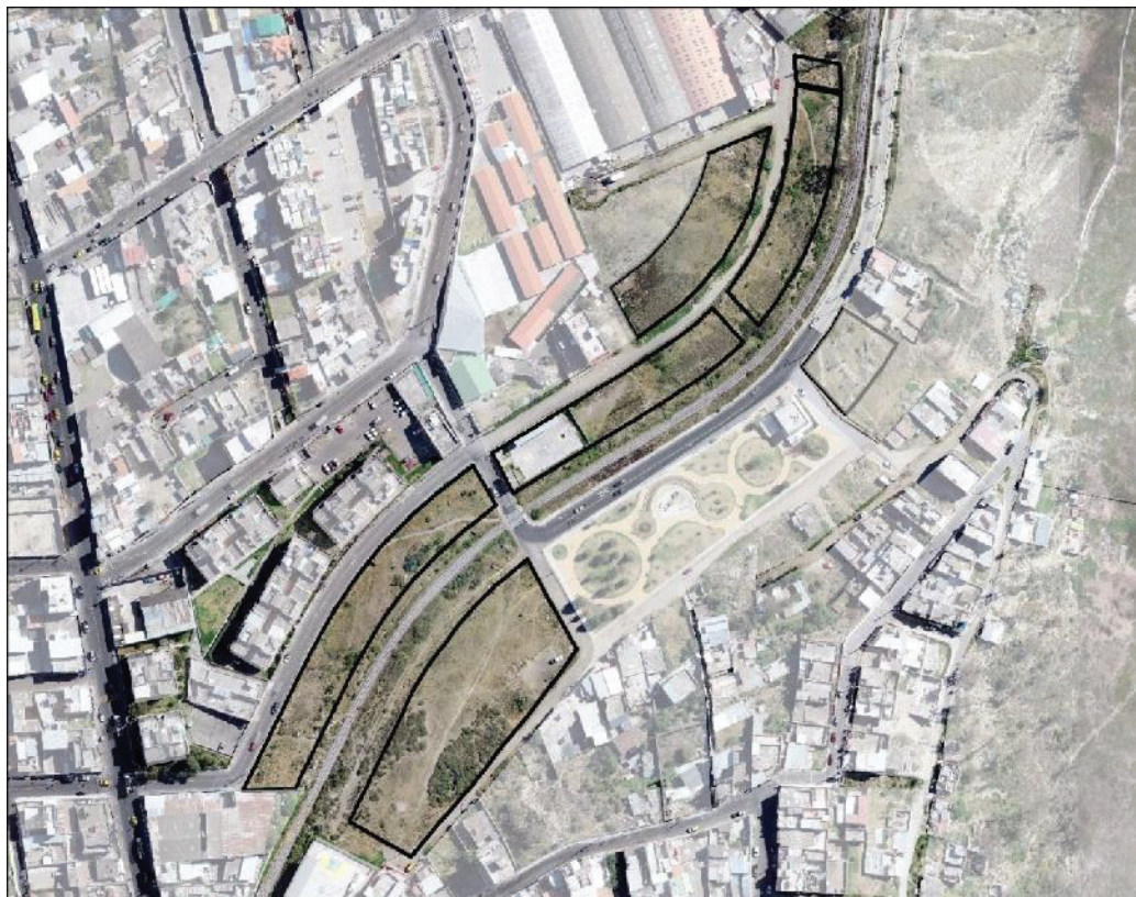
Figura 2. Predios destinados para vivienda de interés social ubicados en el Barrio Miraloma
